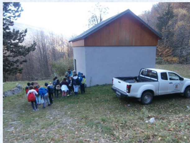
Local usine traitement des eaux
