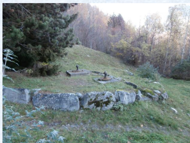
Répartiteur des eaux
