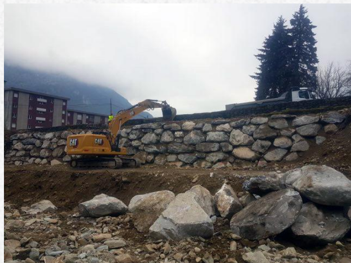
Création d'un enrochement à la place des gabions sur le ruisseau des Perelles.
