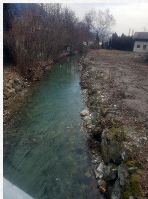
Sécurisation de la berge de Lescherette en aval du pont vert.
