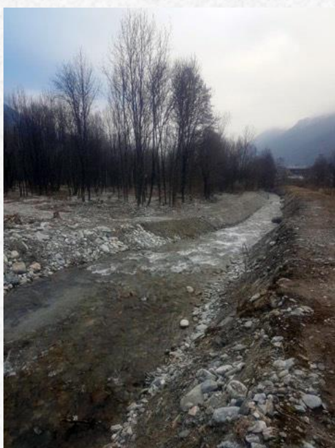
Digue de Lescherette au niveau des maisonnettes.
