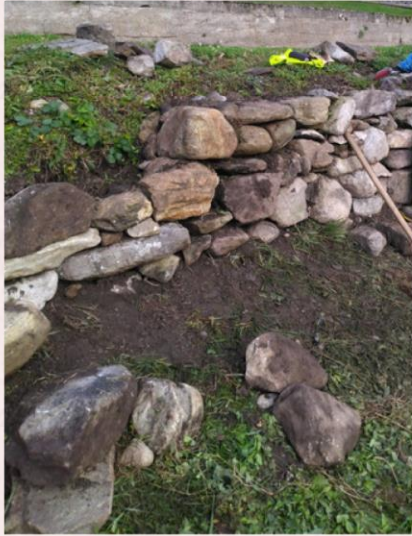
Réfection à l'identique d'un mur en pierre sèches
