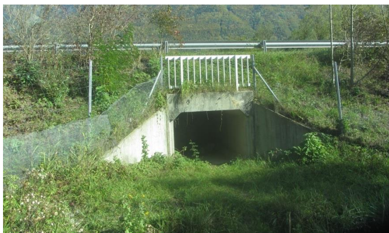
Passage busé sous l'autoroute
